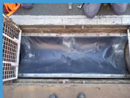
↑ Une bâche a été installée sous la trappe pour limiter l'impact sur les odeurs de surface.
