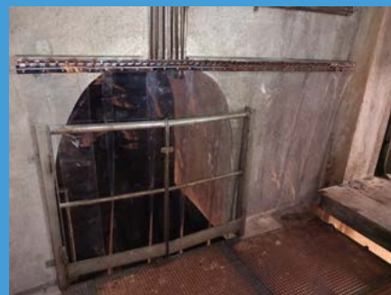
↑ Au niveau des collecteurs, des bavettes souples ont été installées à l'aval de la chute pour limiter l'impact du dégazage sur les odeurs en surface.
