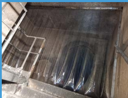
↑ Au niveau des collecteurs, des bavettes souples ont été installées à l'aval de la chute pour limiter l'impact du dégazage sur les odeurs en surface.
